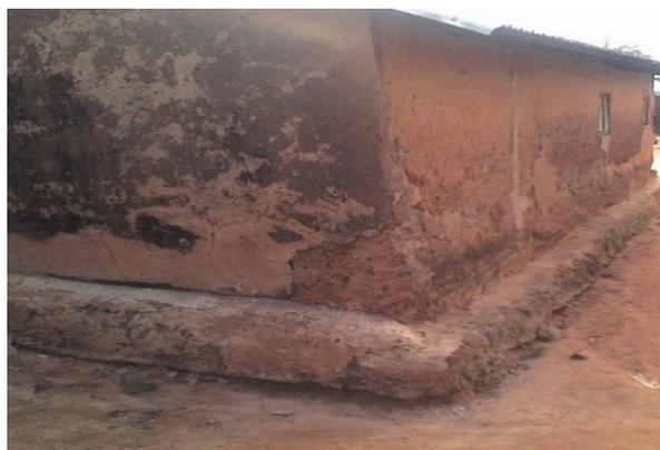
**Figure 13: Bâtiment Dont Le Soubassement Est Renforcé Par Une Terrasse En Maçonnerie A Kantaborifa.**
