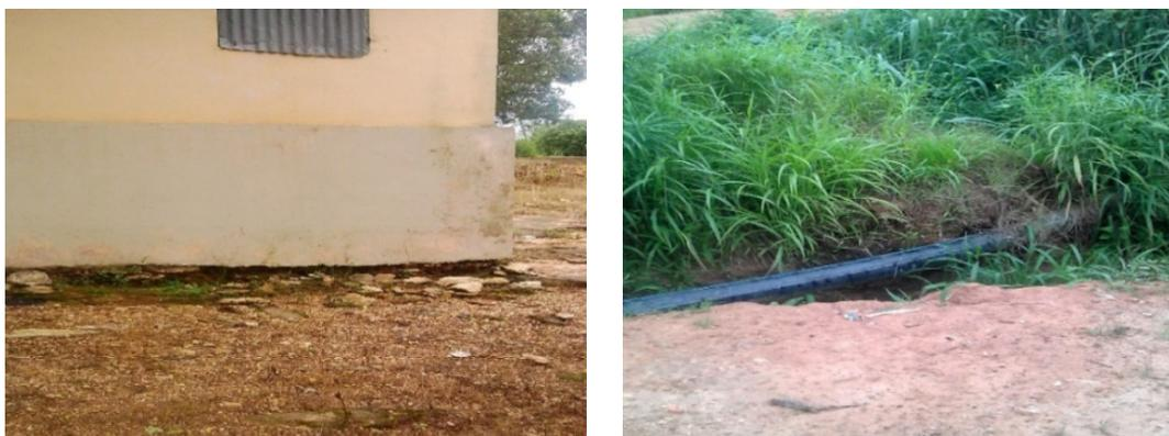
**Figure 12: Maison Dont La Fondation Est Sapé A Boriyouuré (A), Infrastructure De Distribution D'eau Potable Mis A Nue Par L'érosion Pluviale A Bagri (B).**
