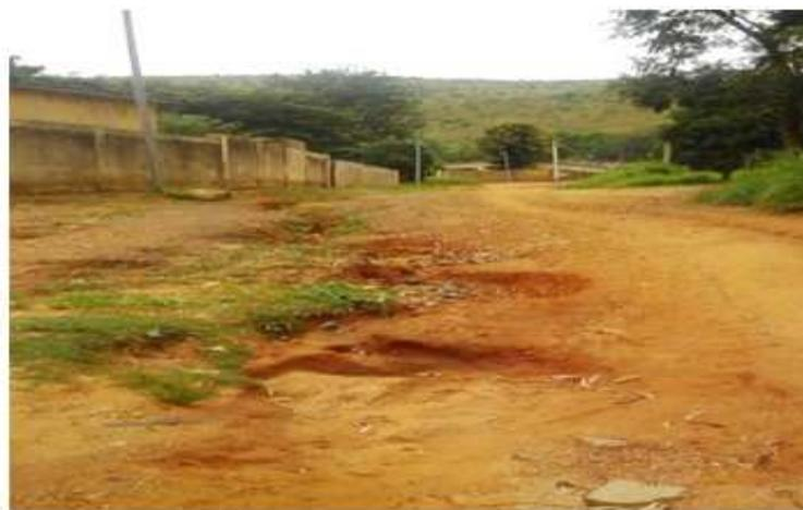
**Figure 10: Une Rigole Laissée Par Le Ruissellement Dans Le Quartier Yokossi.**
