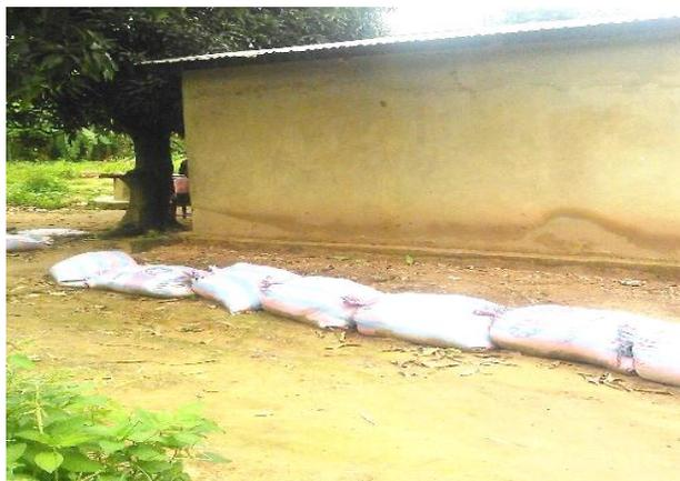
**Figure 15: Soubassement D'une Maison Protégé Par Les Sacs De Sable A Boriouré.**
