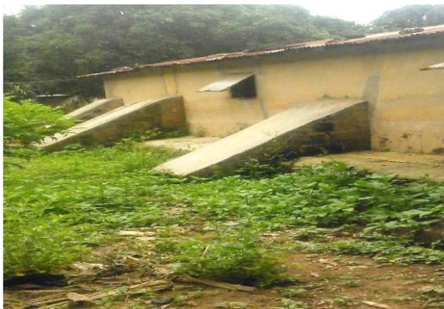
**Figure 14: Bâtiment Maintenu En Equilibre Par Les Piliers, Situé En Aval D'un Versant A Boriyouré.**
